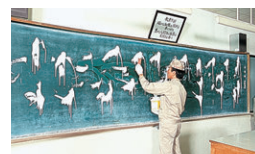
接着剤を板面に塗布
